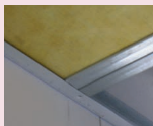
Pose des isolants
