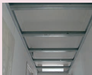
Réalisation de la structure rails/montants
