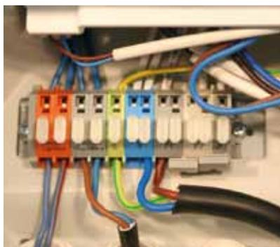
Raccordement électrique (sonde capteurs, contact HC, alimentation)
