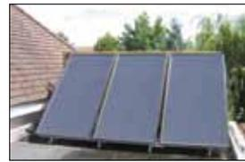
Capteurs sur châssis
