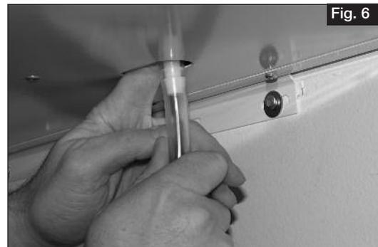
Le rivet de purge pour l'équilibre des pressions ne doit pas être fermé ni recouvert (fig.7/8). Pour éviter les remontées d'odeurs dues à l'assèchement du siphon, nous conseillons de ne pas plonger le tuyau PVC dans le siphon mais d'opter pour un écoulement libre (fig.8). Les condensats sont collectés dans le fond étanche de l'appareil puis évacués vers le réseau EP/EU du logement. L'évacuation doit absolument être branchée sur un siphon.
