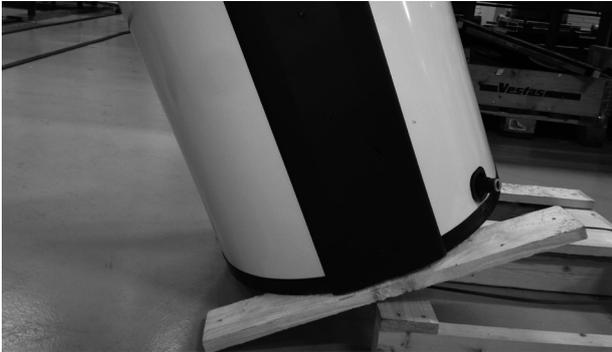
4. Dépose de l'appareil de la palette :
