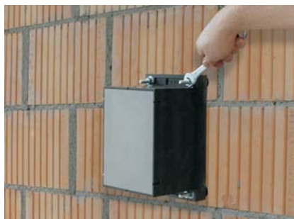
Versetzen der Universalmontageplatte UMP®-ALU-TR.
