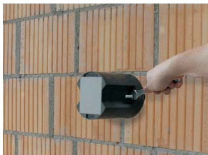
Versetzen der Universalmontageplatte UMP®-ALU-TZ.
