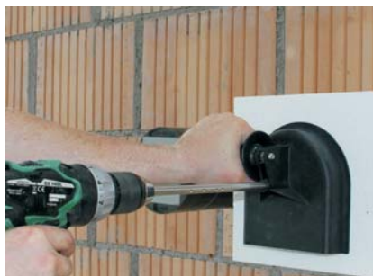
Mit Fräswerkzeug für Montagezylinder Ausfräsung in nicht verklebte Dämmplatte fräsen.
