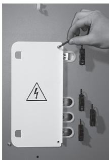
Desserrage 2 vis à l'aide d'une clef ou d'un tournevis Torx
