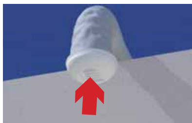
L'air est extrait des pièces techniques à une température stable.
