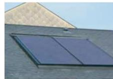
Capteurs intégrés au toit
