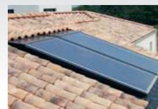
Capteurs intégrés au toit
