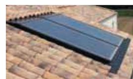
Capteurs intégrés au toit
