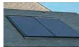
Capteurs intégrés au toit
