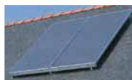
Capteurs posés sur le toit
