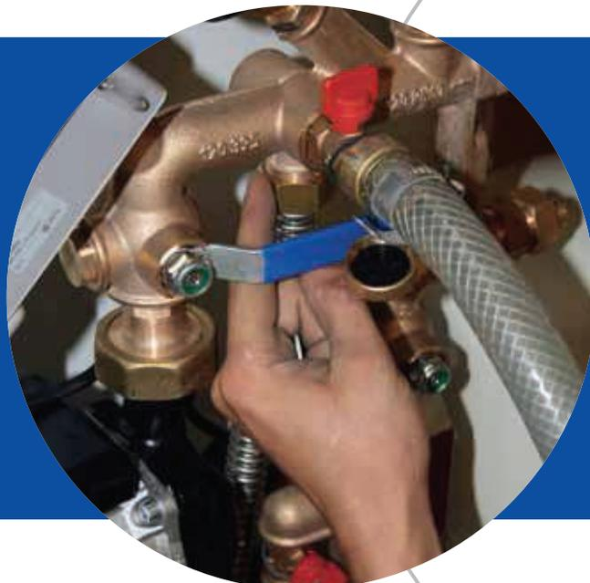
Étape délicate et primordiale de l'installation, le raccordement hydraulique varie selon les modèles de chauffe-eau ou le type de montage à réaliser.
