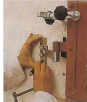
3. Installation du gond et repérage du trou intérieur. Perçage Ø 10.
