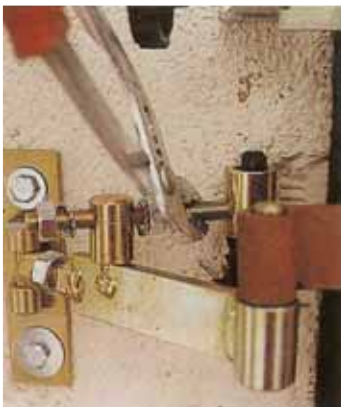
7. Vissage de la tige filetée sur l'ancien gond à travers la douille.
