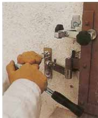
5. Perçage du trou supérieur à travers la platine. Mise en place de la cheville et vissage du tire-fond en utilisant la rondelle du plus petit diamètre.
