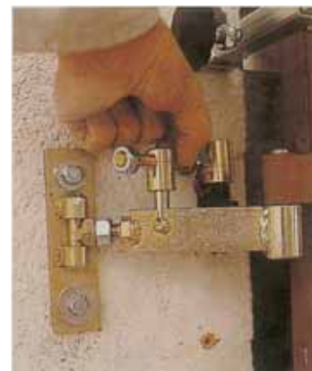
6. Positionnement de la pièce de raccordement sur l'ancien gond.
