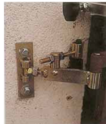
9. Gond ISO mis en place, prêt à isoler.
