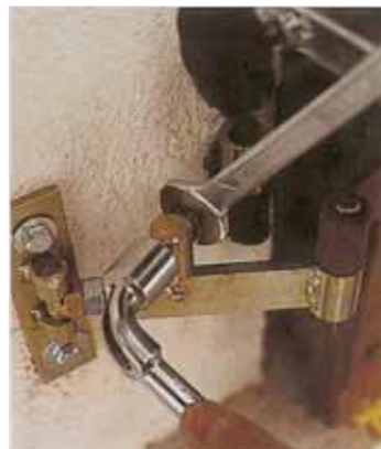
8. Blocage des 2 écrous en simultané, pour garantir le bon maintien de l'écartement.
