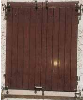
1. Mise en place du volet décalé, à l'aide des gabarits I.N.G. (voir photo) ou possibilité d'utiliser 2 tasseaux bois.
