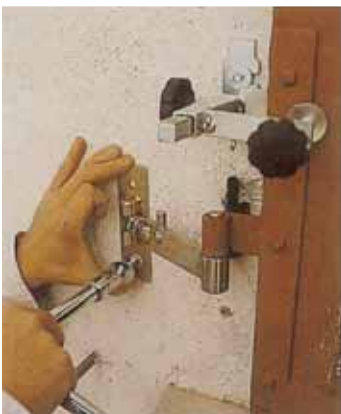
4. Mise en place de la cheville et vissage du tire-fond en utilisant la rondelle du plus gros diamètre.
